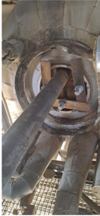
شکل (۴) درب جدید ساخته شده درام و مسیر برگشت اسیدشویی
